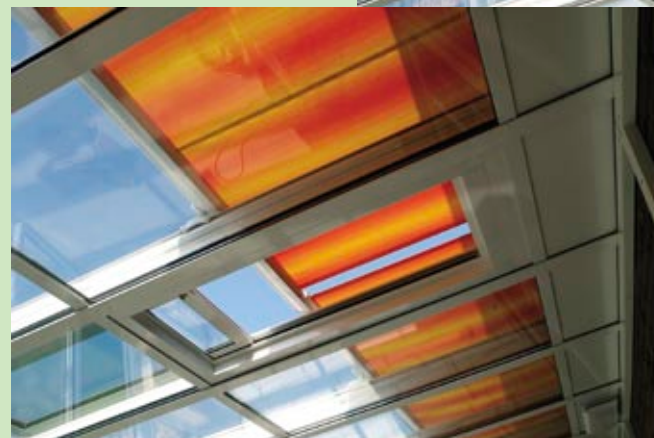
Eine geringe Bauhöhe bei Dachlüftern sorgt dafür, dass Außenbeschattungen weiterhin problemlos funktionieren können.
