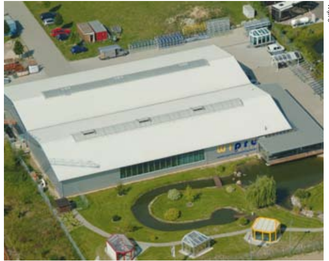
Das Firmengelände der Wipro GmbH & Co. KG in Brehna.
