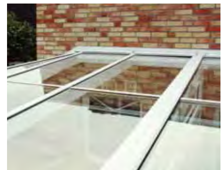
Die Aluminiumkonstruktion wurde mit Ankerstangen und Injektionsmörtel in der Außenwand verankert.
