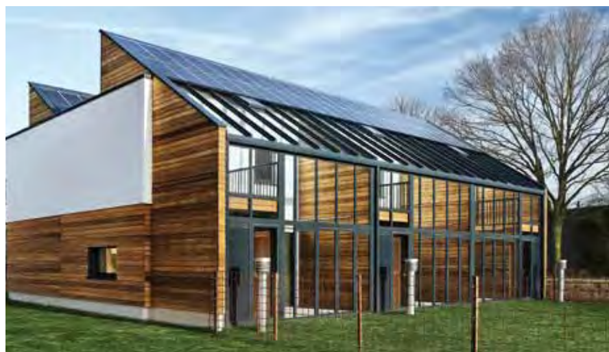
Die Firsthöhe des Wintergartens liegt bei 6,37 Metern.
