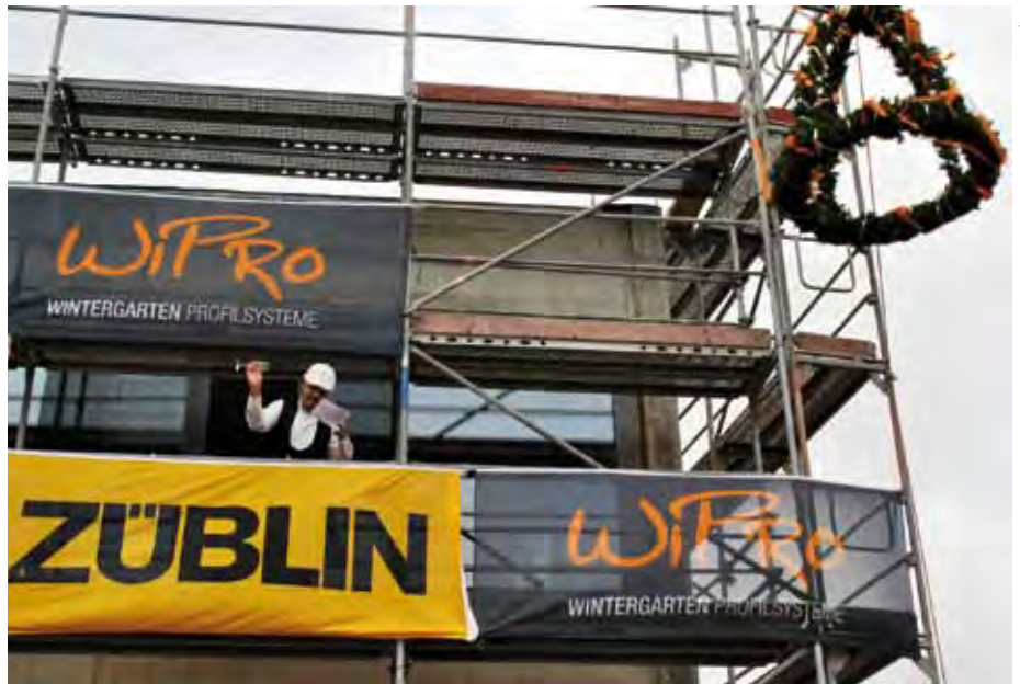
Den Richtspruch brachte Polier Thomas Josten dar.
