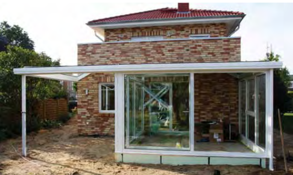
Der Wintergarten in Norderstedt besteht aus einer vorgefertigten Aluminiumkonstruktion.
