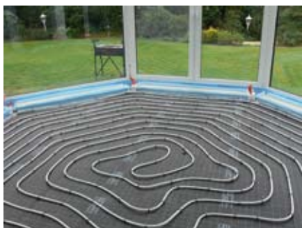
Heizschlangen für eine Fußbodenheizung werden verlegt. Soll die Beheizung des Wintergartens auf die sich schnell verändernde solare Einstrahlung reagieren können, reicht diese Form der Beheizung nicht aus.
