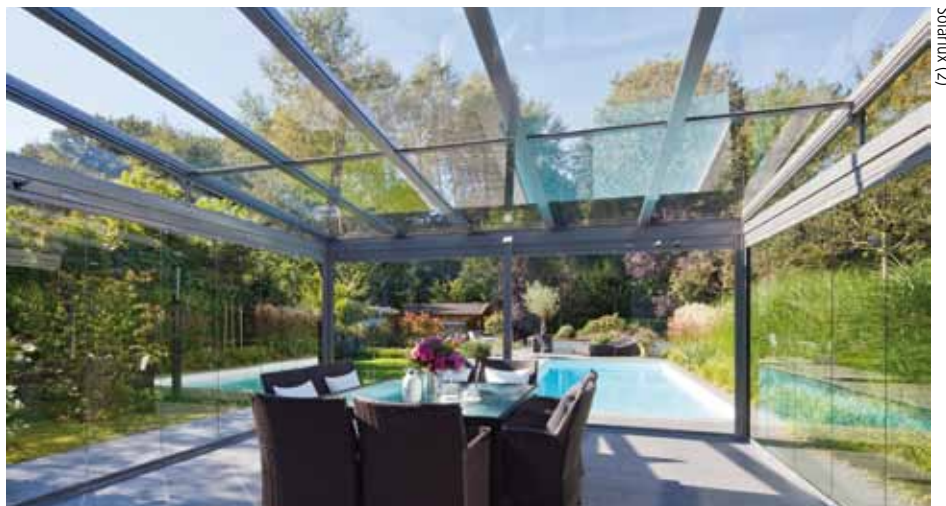
Die filigrane Dachkonstruktion des Glashauses ist mit 23 senkrechten, beweglichen Ganzglas-Elementen kombiniert.
